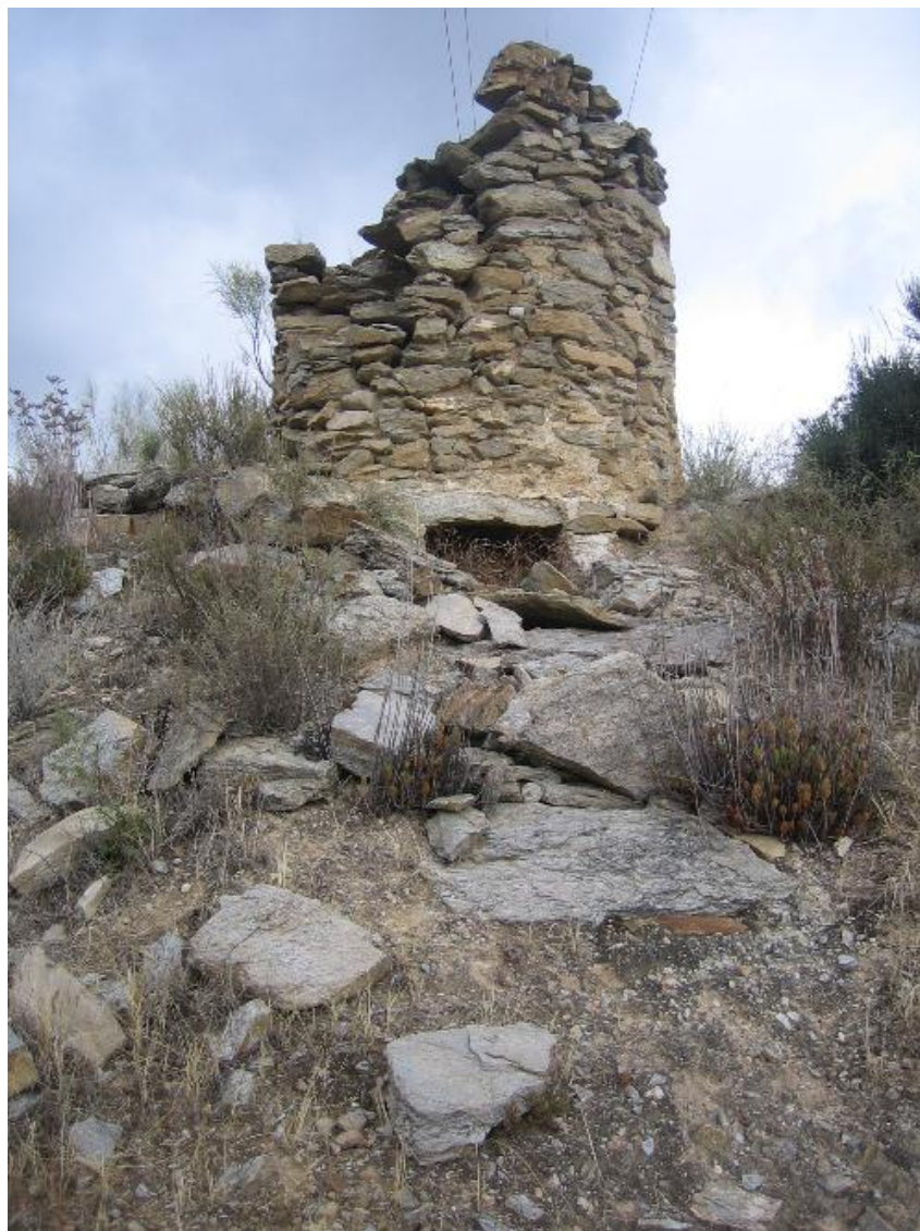
FOTOGRAFÍA 17. No todas las estructuras descubiertas en Bédar tienen fácil explicación. En terrenos de la concesión minera de Mahoma se puede observar la base de una pequeña chimenea ubicada en lo alto de un cerro a la que accede una pequeña galería excavada en el terreno y cubierta con lajas de esquisto que desciende por el cerro hasta unos vaciaderos de lo que parece mineral de hierro. Tras una consulta con un especialista en las minas de la vecina sierra de Almagrera, Antonio González, la estructura fue identificada por su enorme similitud como una galería y chimenea de ventilación del mismo tipo que las usadas en esta sierra para los pozos de las minas de plomo. Es la primera descripción de una estructura de este tipo en Bédar y la primera en una mina de hierro. Fotografía J.A. Soler.
