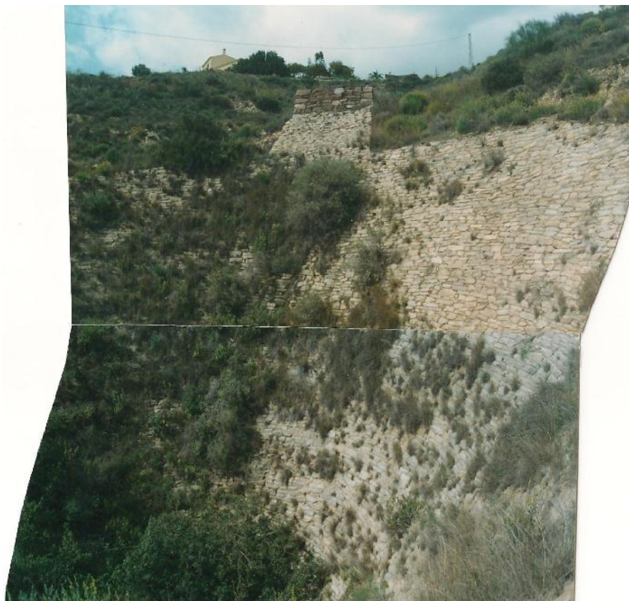
FOTOGRAFÍA 10. Fotografía parcial de la Tolva Embudo de Tres Amigos, se aprecia el resbaladero de la tolva y una sección de la pared de la misma en la que se aprecia la calidad del trabajo. Fotografía G. Leal.
