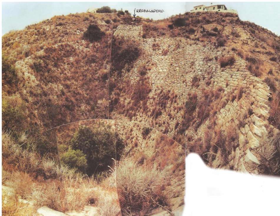
Fotografía 11- Tolva en embudo de Tres Amigos, final del ramal de tren de la mina Mulata . La única compuerta de la tolva cargaba directamente sobre los vagones del tren, que accedían a ella por medio de un espacioso túnel ubicado bajo la tolva.
