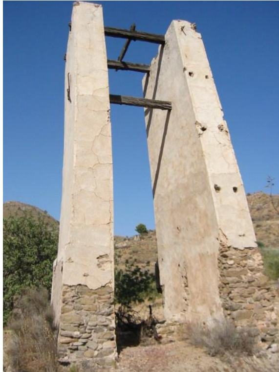
Fotografía 25- Castillete del pozo P , en la mina Mahoma , adyacente al Hoyo Júpiter .
