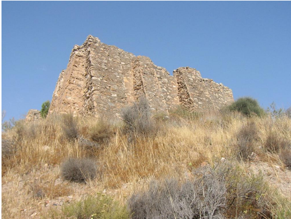
Fotografía 18- Tolva de los Ingleses, tolva de carga junto a la primera trinchera del cable Serena-Garrucha que daba servicio a la mina Higuera cuando era explotada por el vicecónsul inglés en Garrucha, de ahí el nombre.
