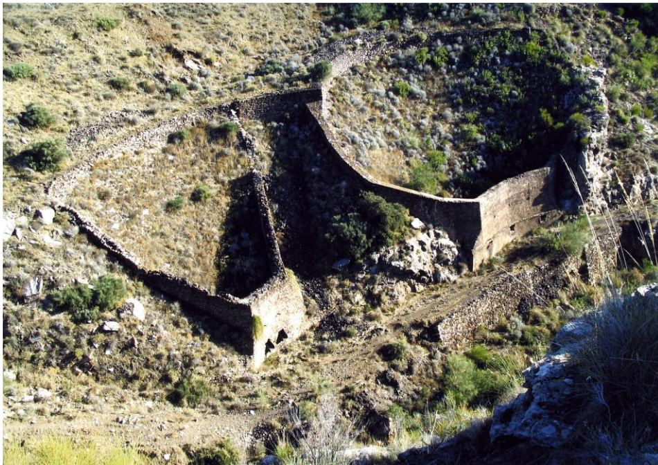
Fotografía 21- Tolvas de Vulcano , tolvas de depósito que aprovechan la pendiente natural del terreno.
