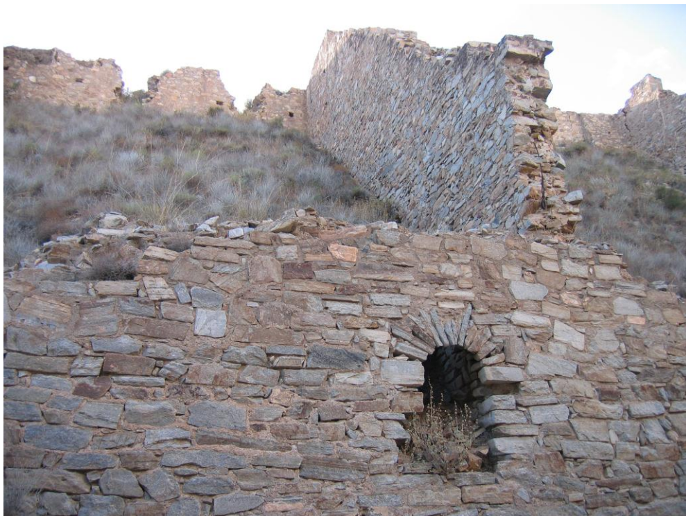
Fotografía 9- Tolva-cargadero de la Trinchera Villalta, recogía el mineral del cable aéreo procedente de Serena para la carga en el ferrocarril Tres Amigos-Garrucha después del levantamiento parcial del cable en 1919.
