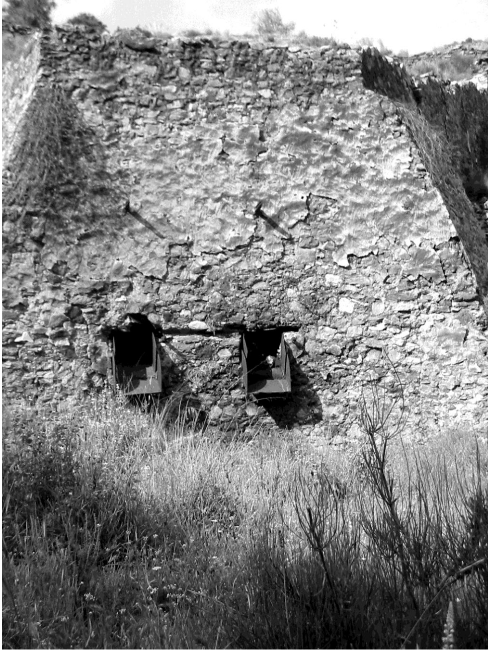
Fotografía 22- Compuertas metálicas en las tolvas de Vulcano , enlazando la vía minera procedente de la mina Esperanza con la de Vulcano .
