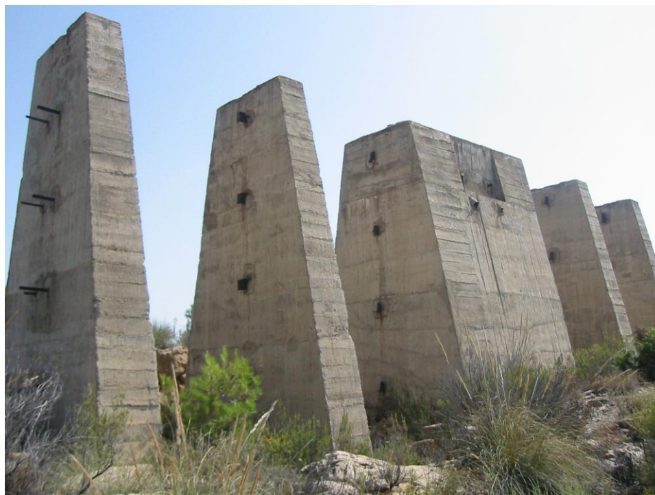
Fotografía 19- Restos de la instalación de la Tensora del cable que conectaba la estación de Serena con el cargadero de Los Gallardos.
