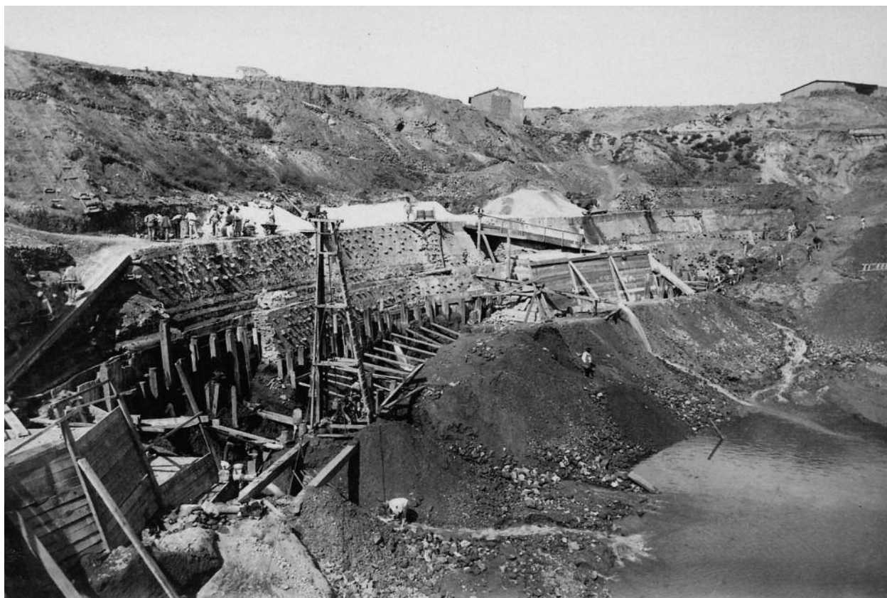
Figura 4. Obras de construcción del muro de contención de la balsa del desagüe en Herrerías (Archivo Gustav Thorkildssen, cortesía de Tuva Halbo).
