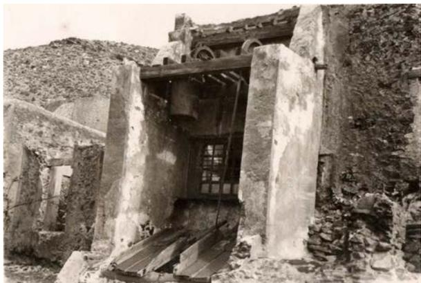
Figura 19. Castillete con sistema de cubilotes del pozo de la mina Venus Amante en 1947.
