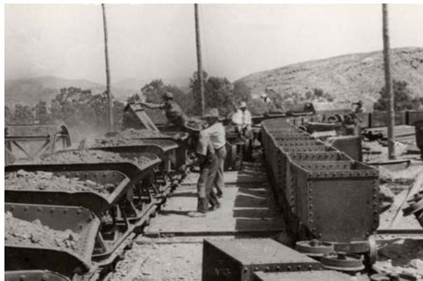
Figura 13. Tareas de descarga de un tren cargado de vagonetas basculantes en el molino del lavadero, una locomotora G 22 se encarga de las maniobras. Junto a ella se encuentra otro tren de vagonetas fijas, algunas de ellas tumbadas. Junio de 1952.
